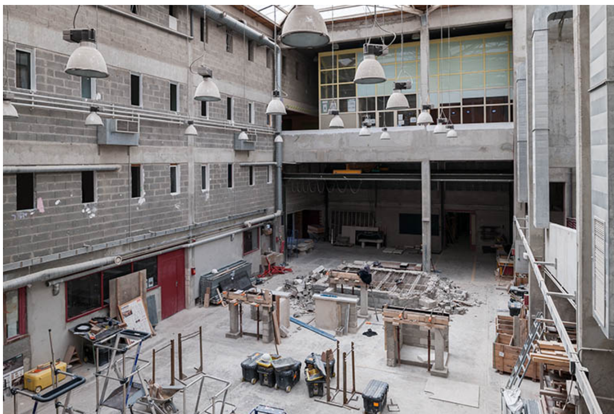
Atelier béton : intérieur, travaux pratiques.
