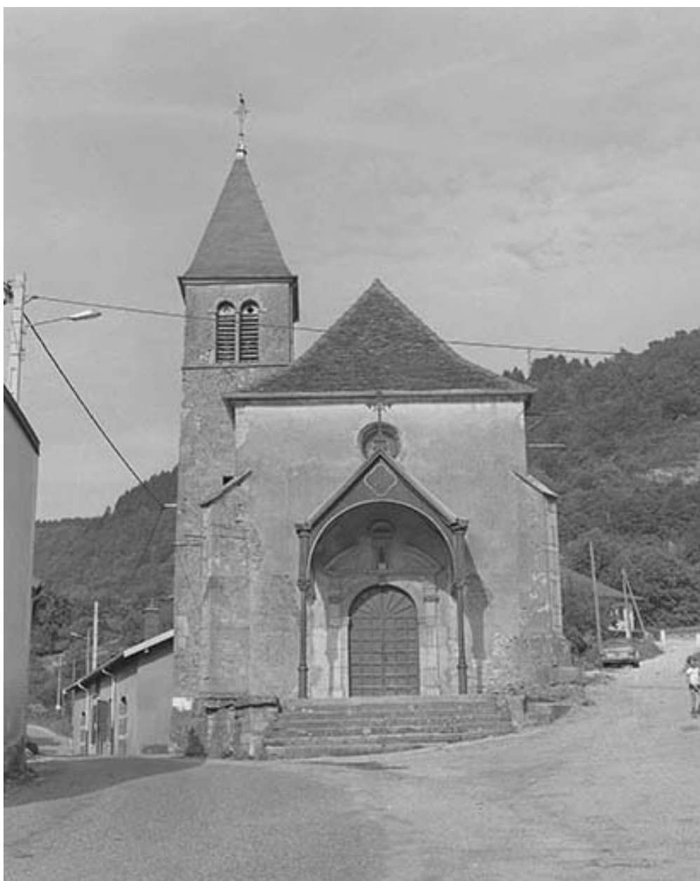
Extérieur : façade antérieure.
