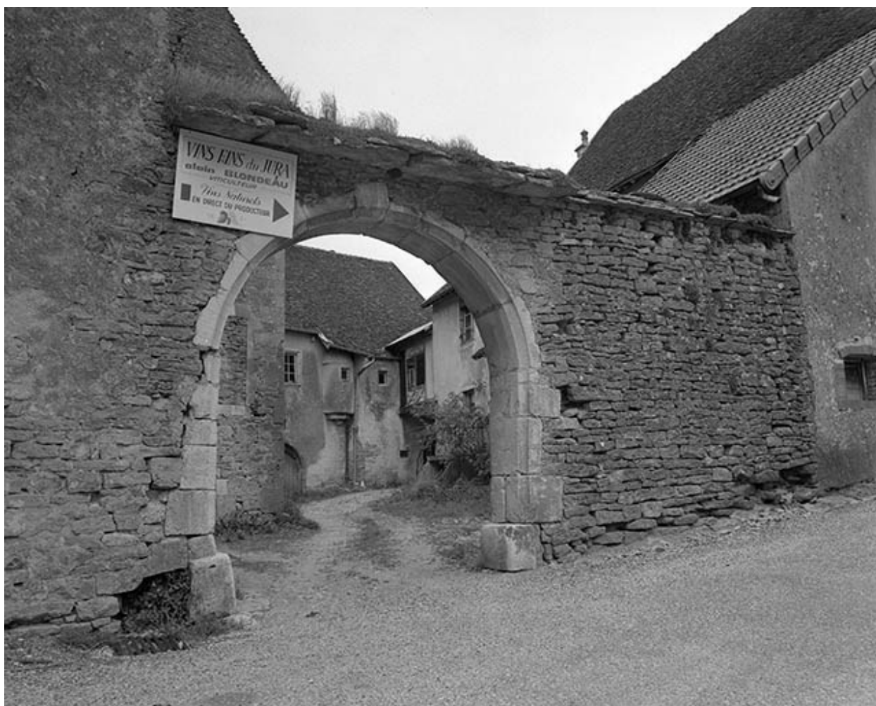
Façade sud : portail d'entrée de la cour.
