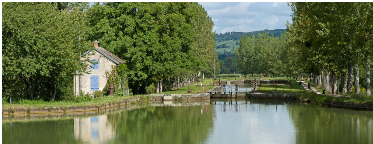
Vue du site d'écluse depuis l'amont.
