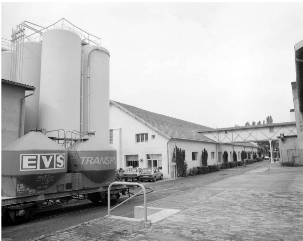
Façades postérieure et latérale gauche des bureaux.
