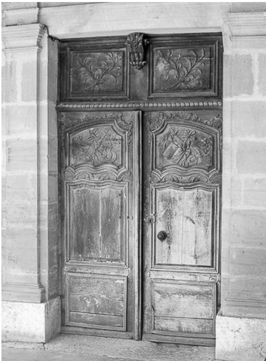
Détail de la deuxième porte d'entrée.
