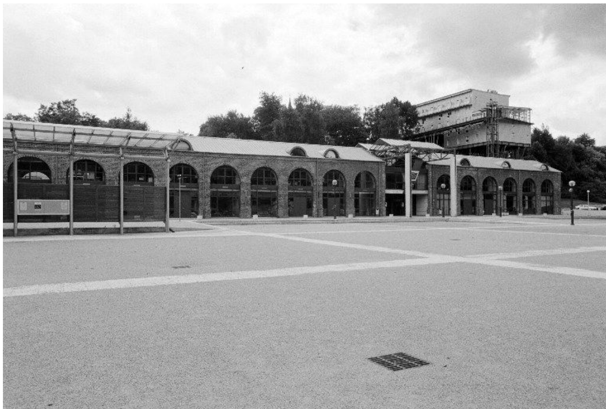
Façade nord de l'ancien atelier d'ajustage (tournerie).
