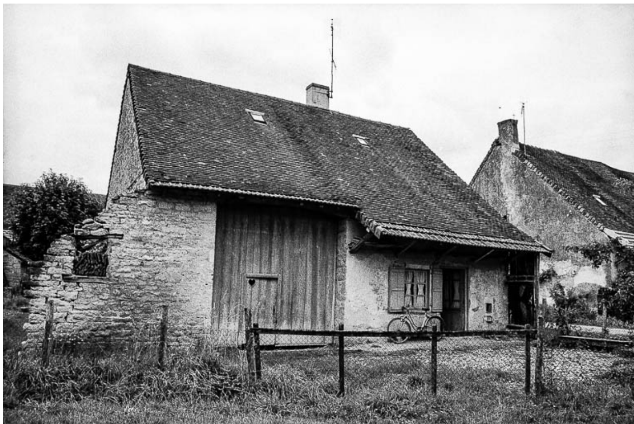
Ferme cadastrée 1949 B1 269 : façade antérieure
