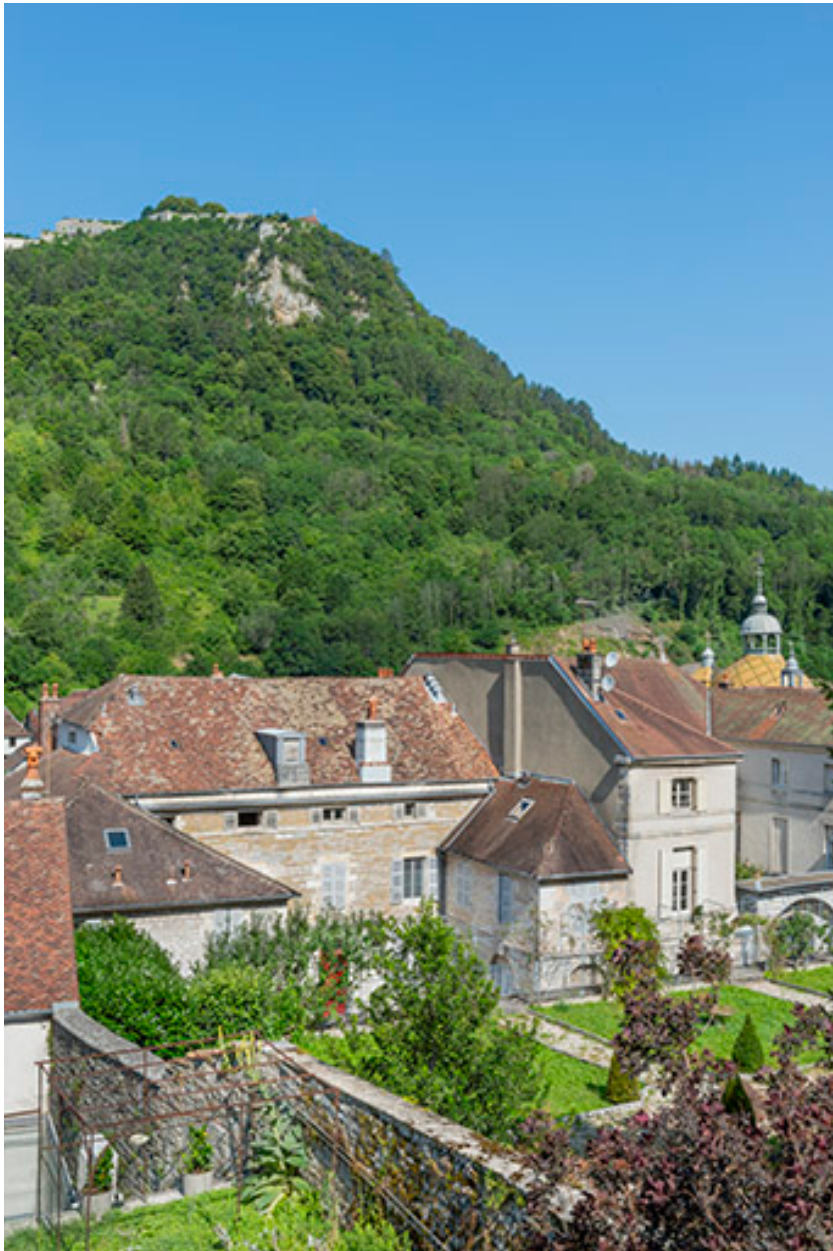
Vue plongeante depuis le sud-est.
