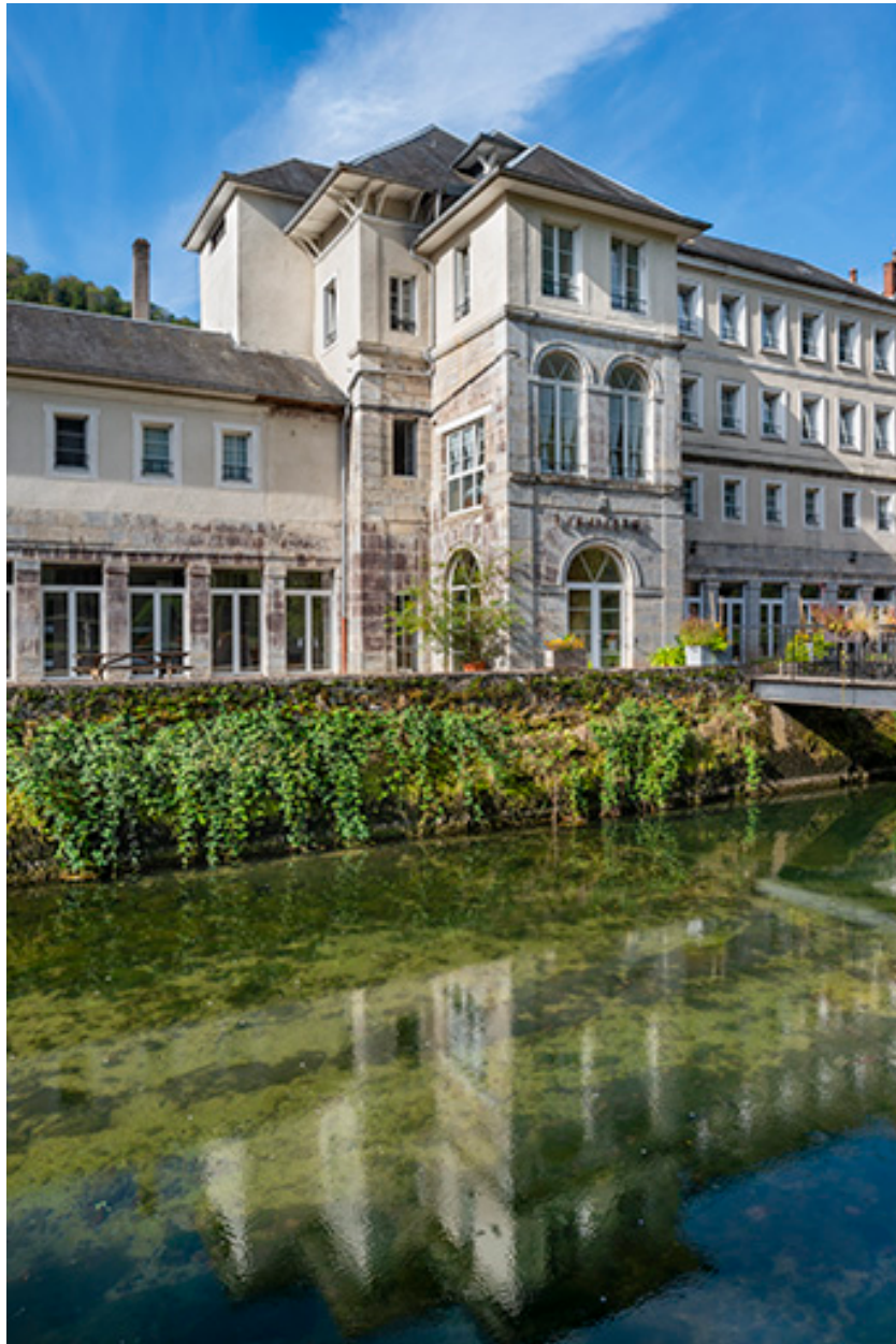
Façade principale, vue de trois quarts, détail.
