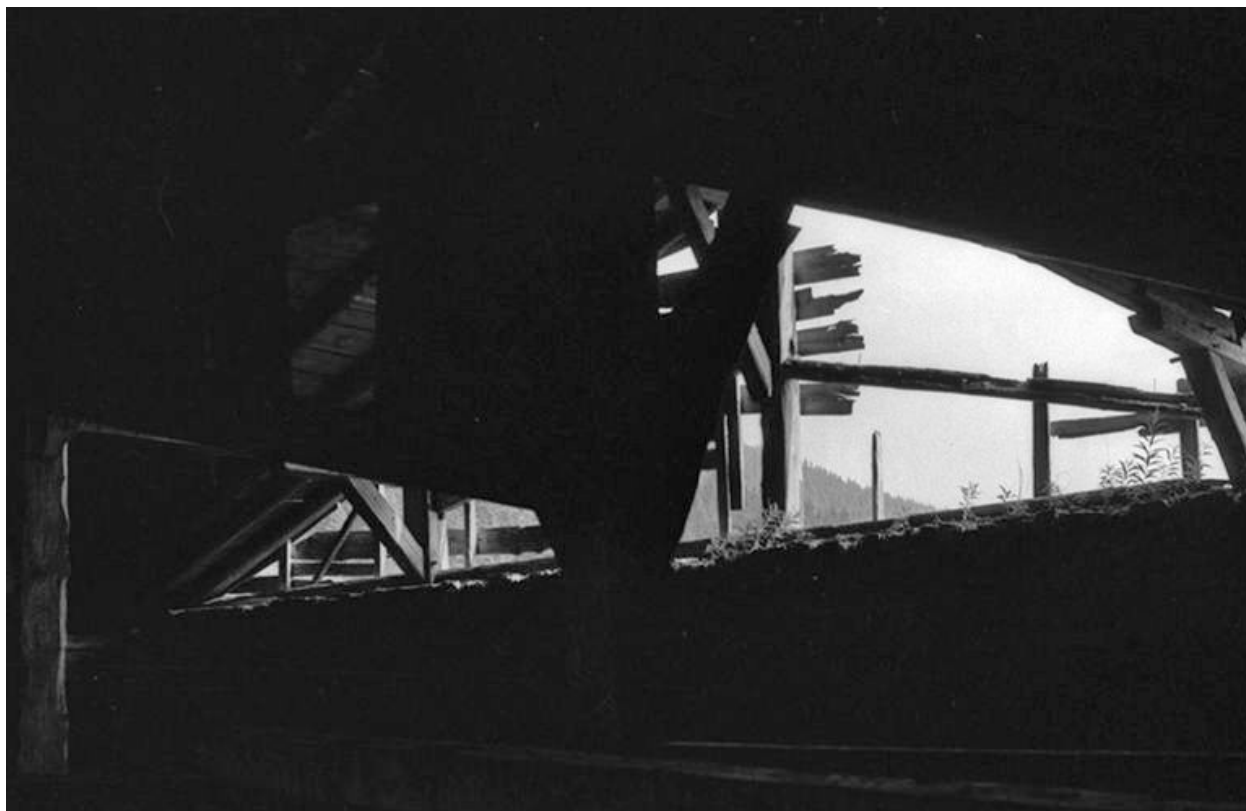
Charpente et "tué".
