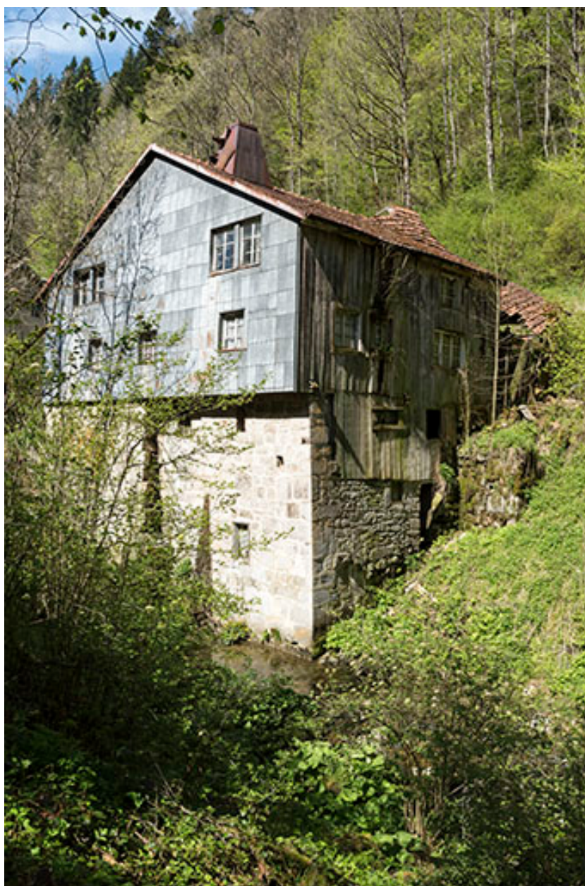
Ancien moulin : façades postérieure et latérale droite.
