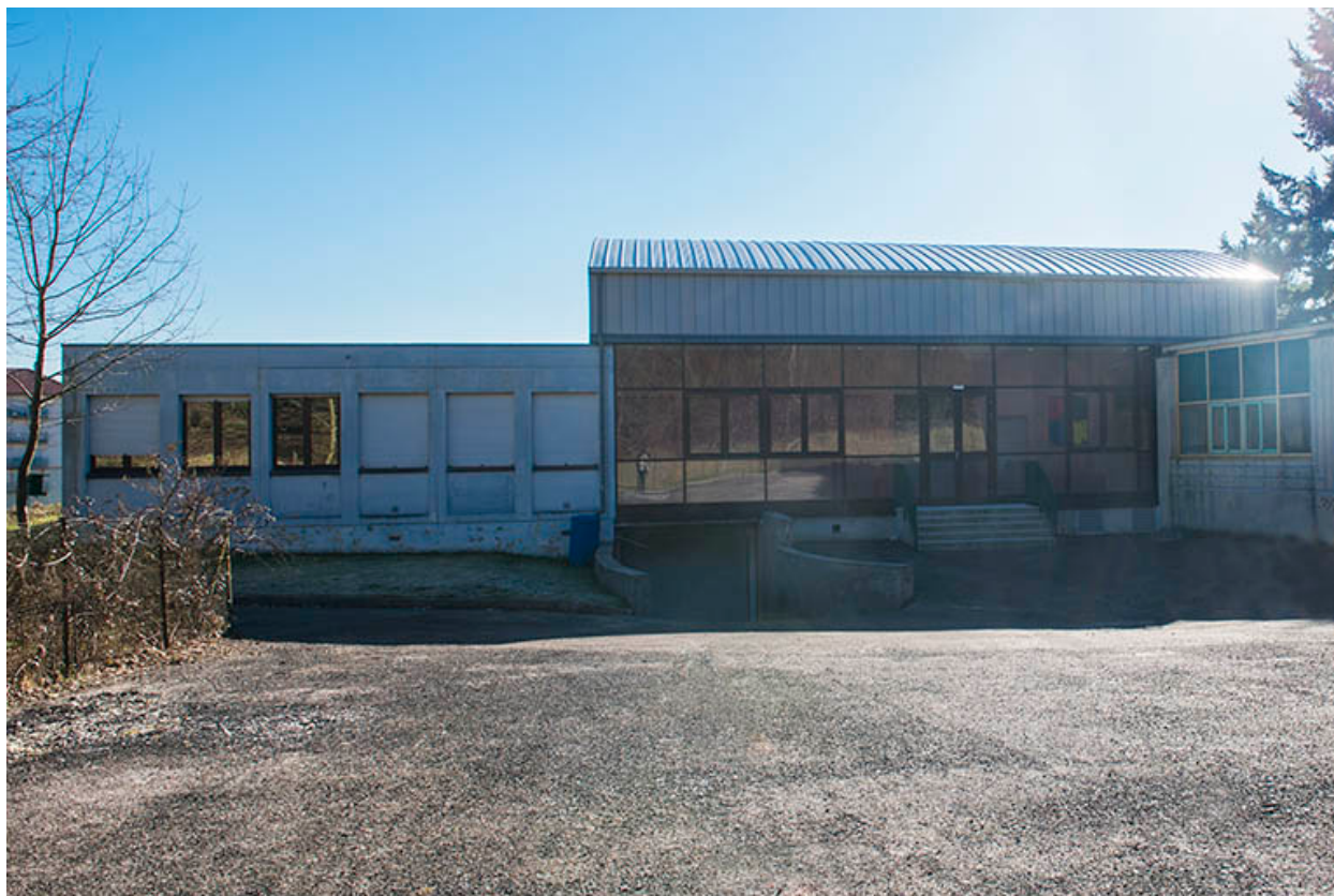
Façade nord-ouest de l'atelier
