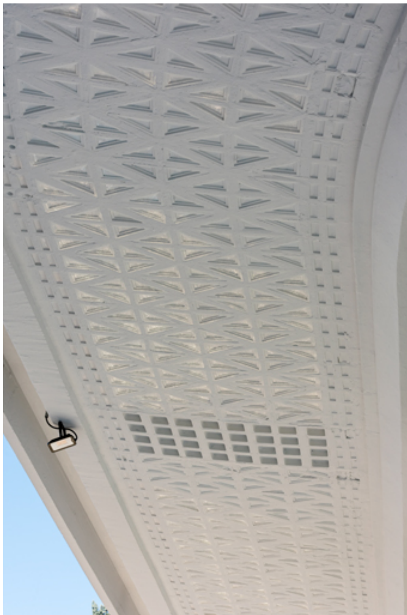
Face inférieure de l'auvent en béton armé.
