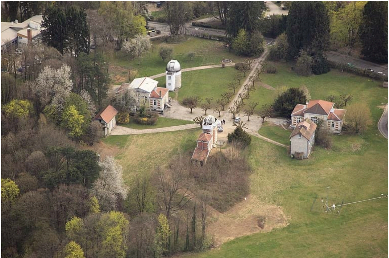
Partie nord : vue aérienne rapprochée depuis le nord-ouest.
