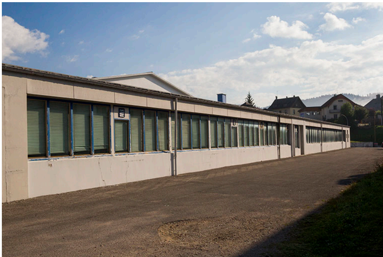
Bâtiment en rez-de-chaussée : façade méridionale.
