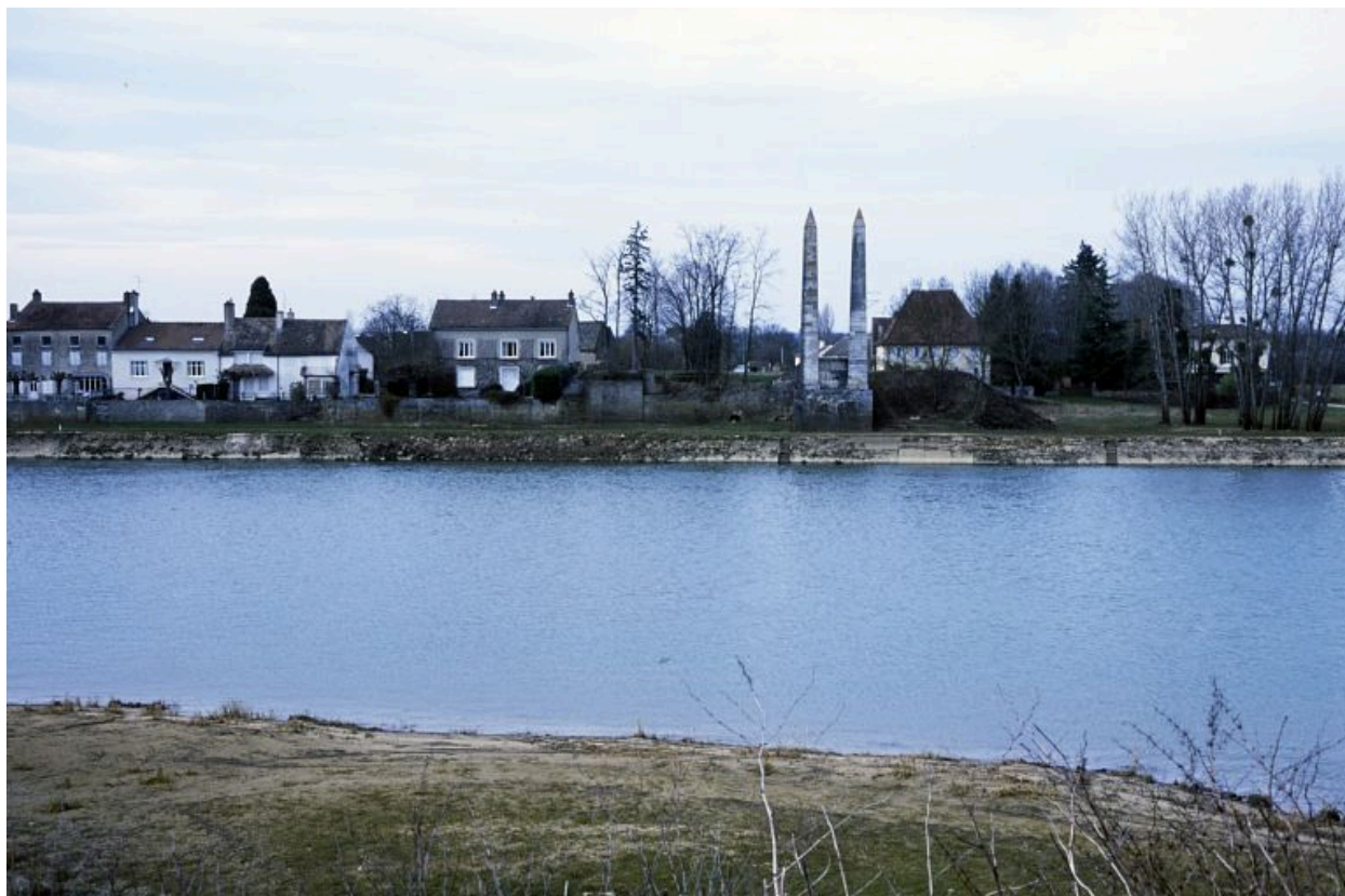
Pylônes, vestiges du pont suspendu en 2003.
