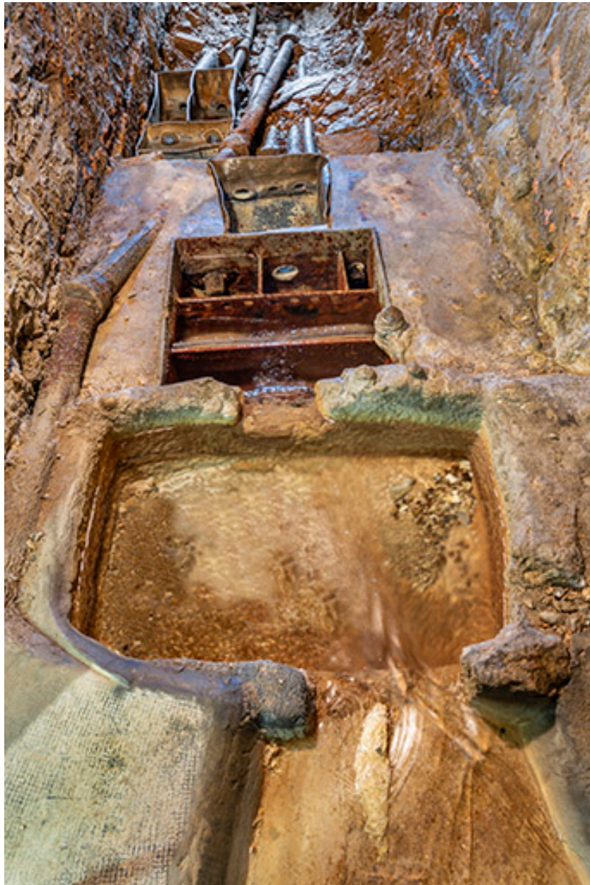
Bassins de division. Vue depuis l'amont.
