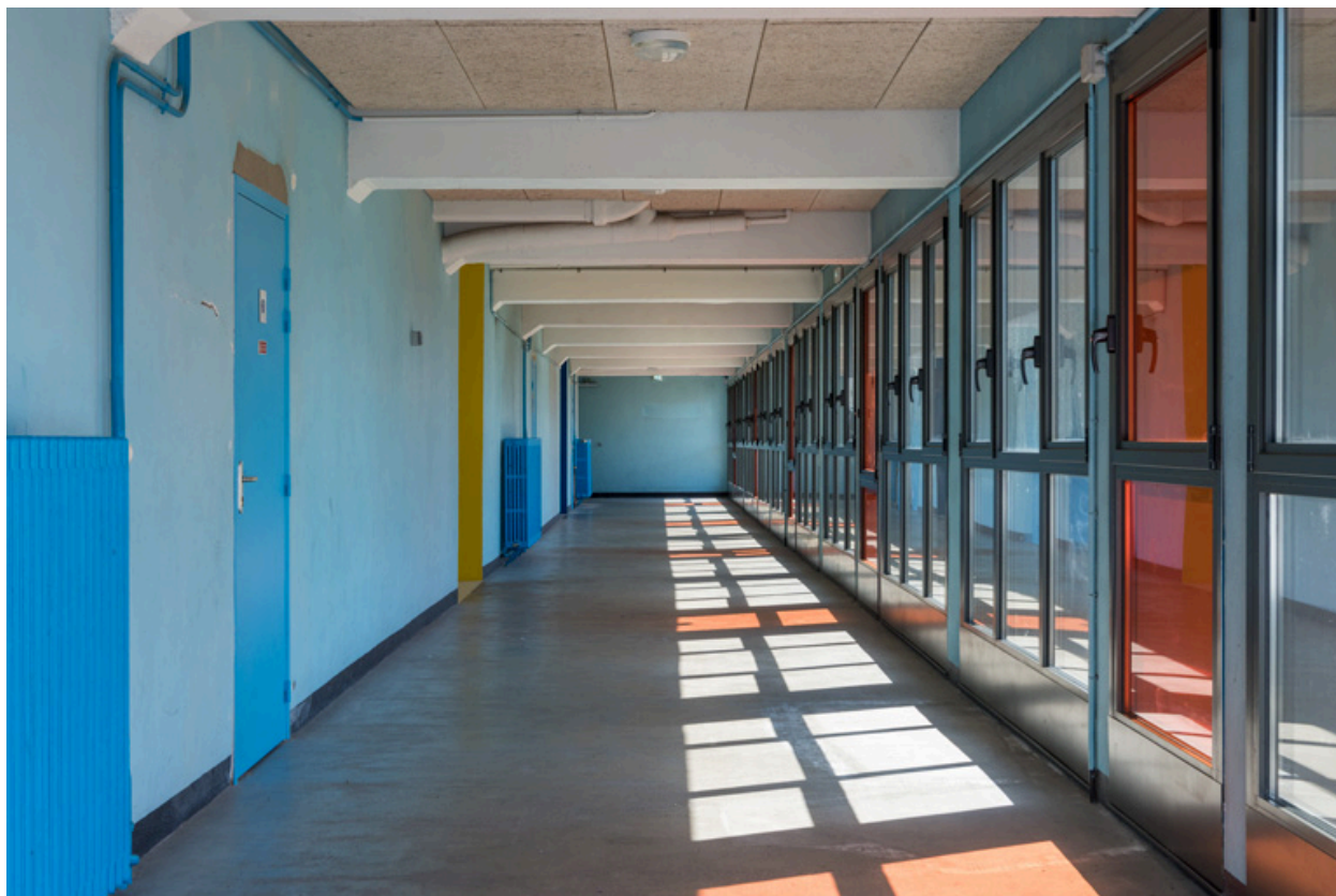
Maison des sports, grand gymnase : galerie vitrée à mi-hauteur des gradins côté Loire.
