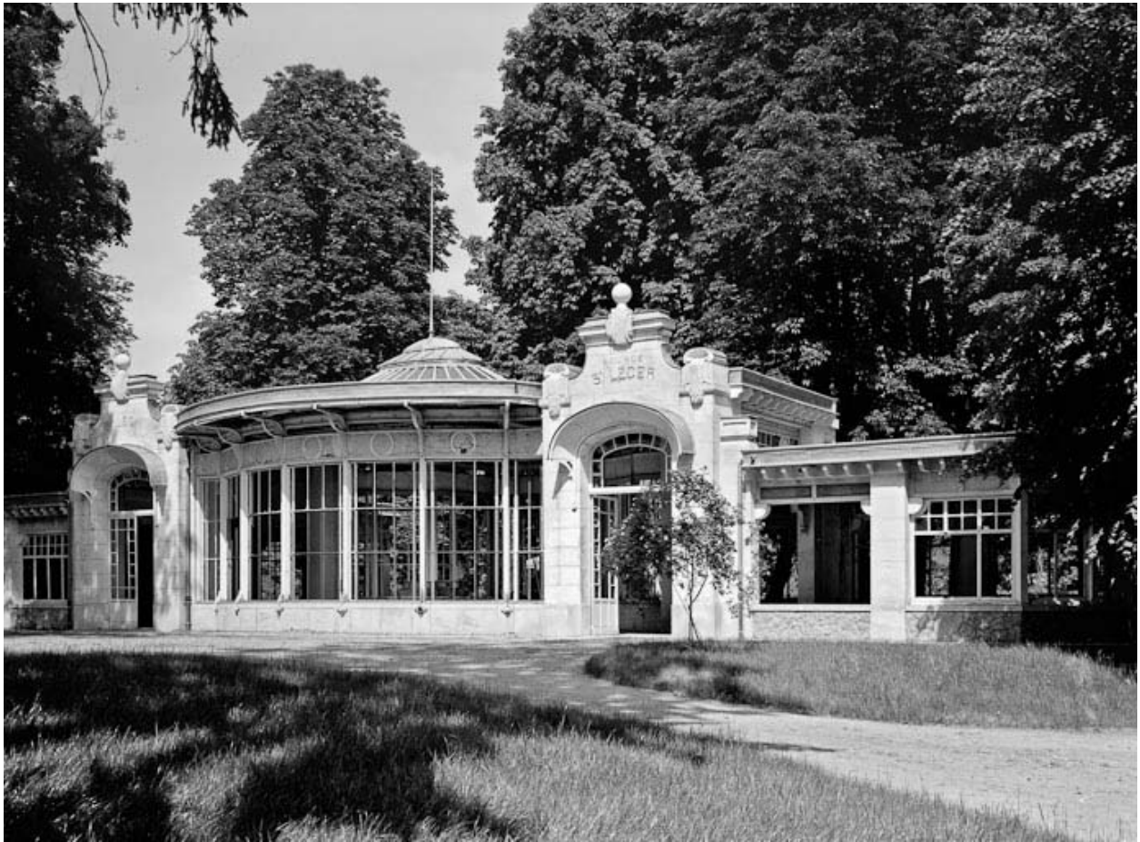
Façade ouest, vue en 1984.
