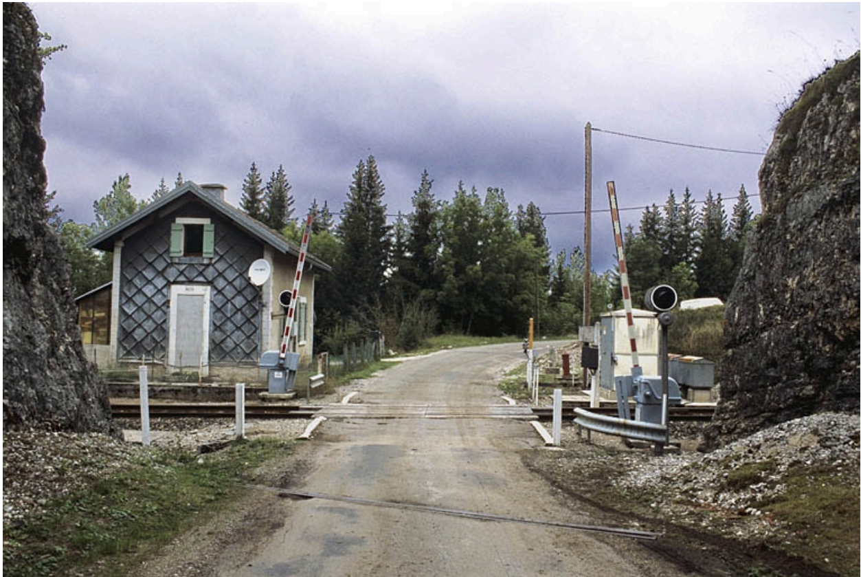
Façade sud (côté voie).
