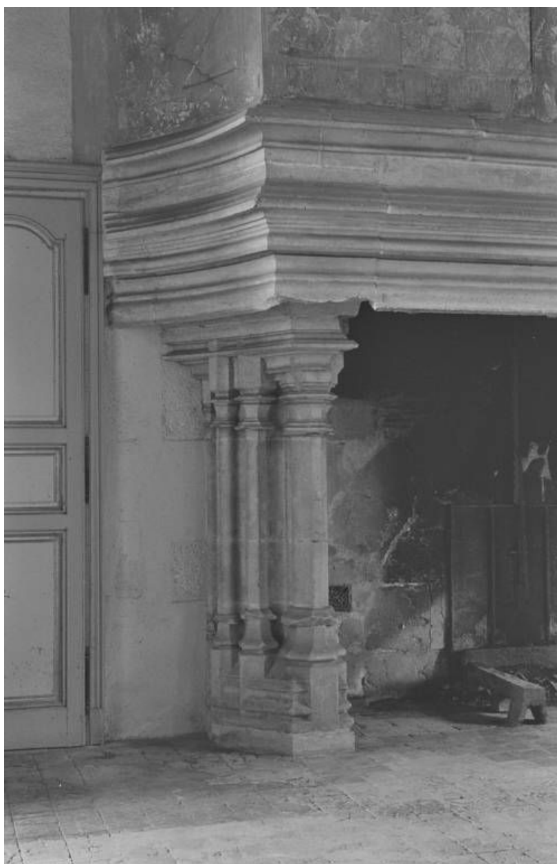
Cheminée (rez-de-chaussée), détail : un montant (photo prise en 1969).
