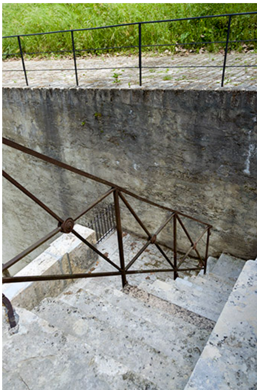
L'escalier et le garde-corps.
