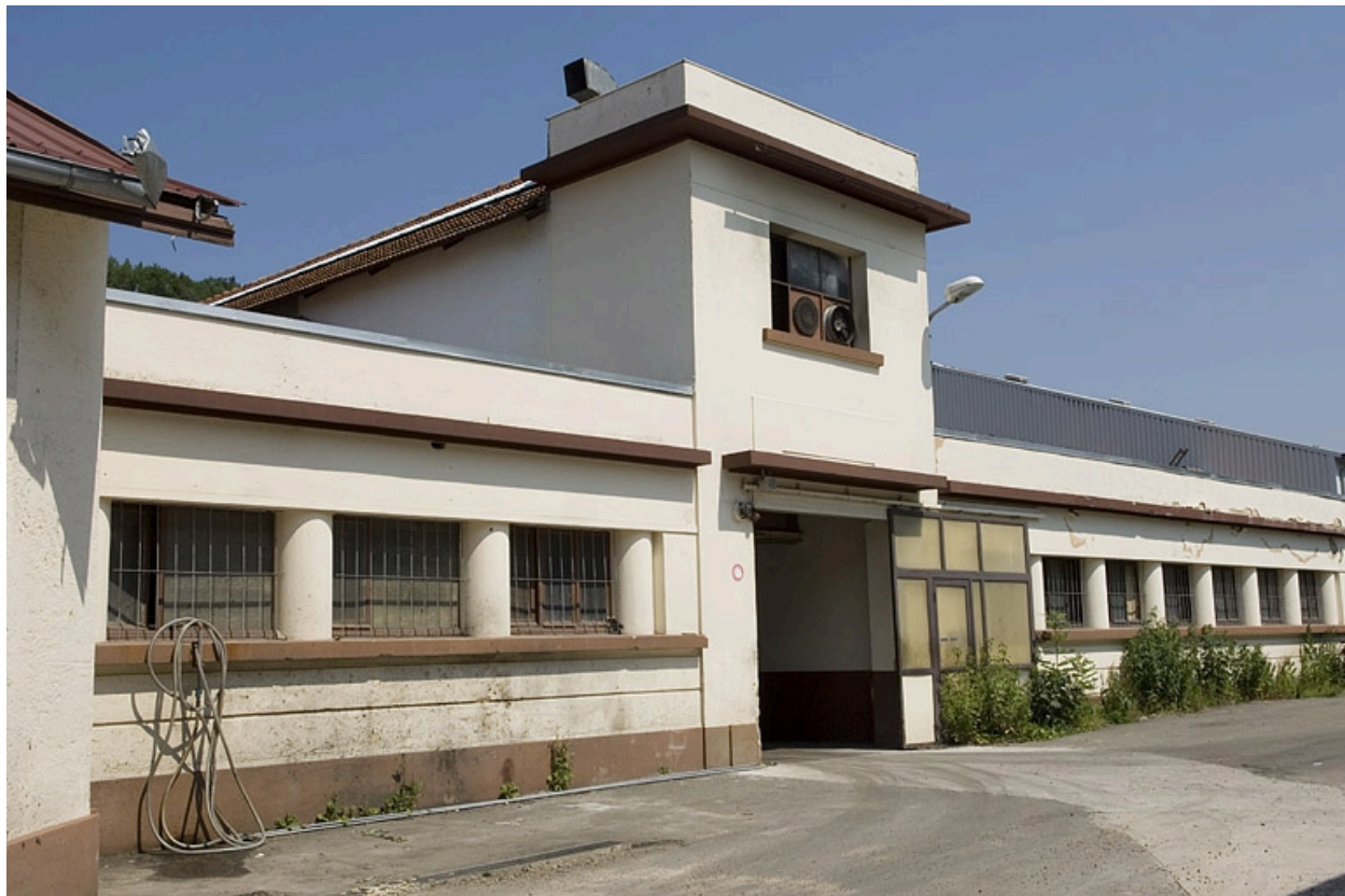
Façade antérieure de l'atelier de fabrication.
