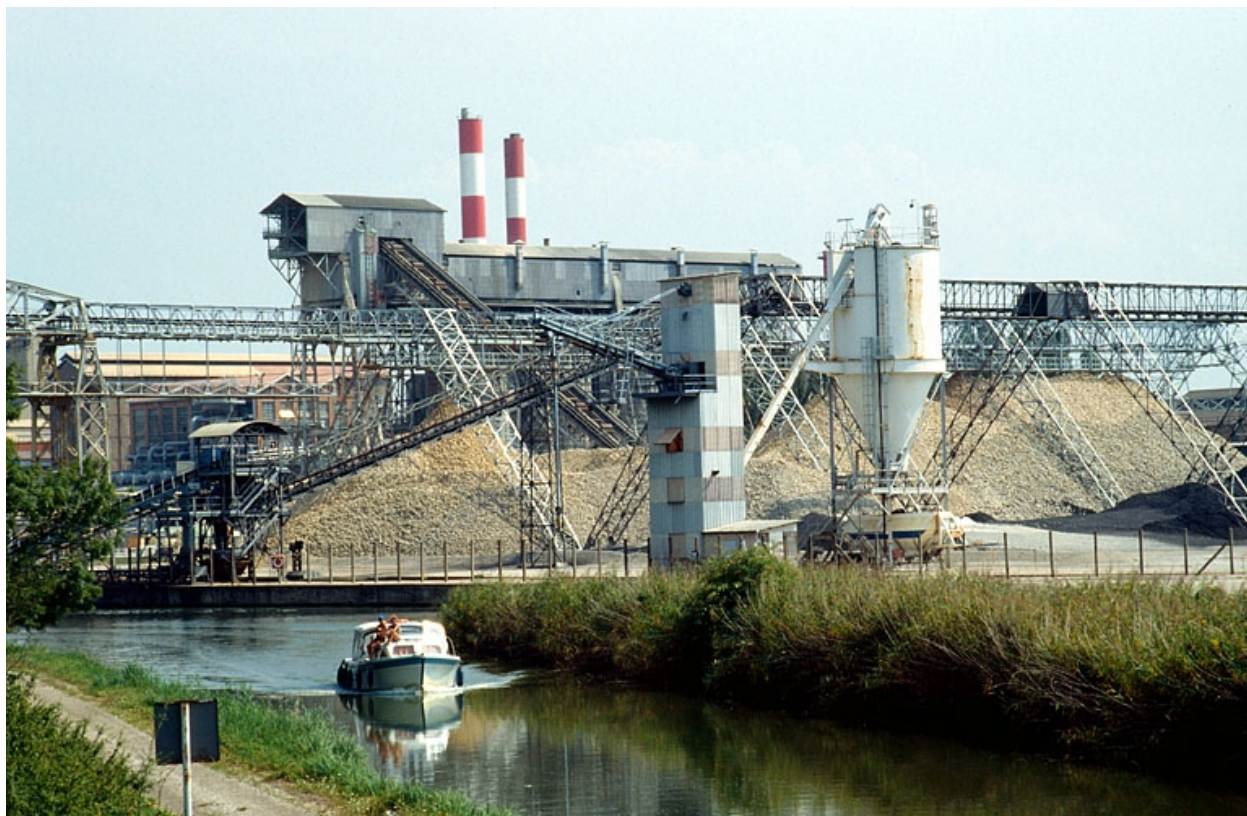
Fours à chaux (9) et aire des matières premières (7) vus du nord-ouest.
