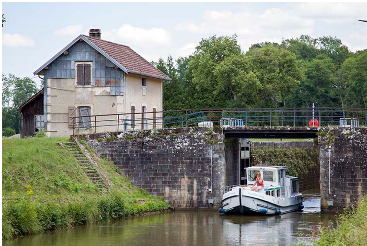
L'écluse, depuis l'aval.
