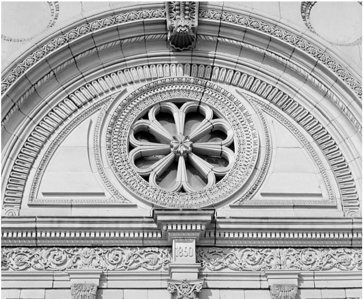
Façade principale, tympan du portail.
