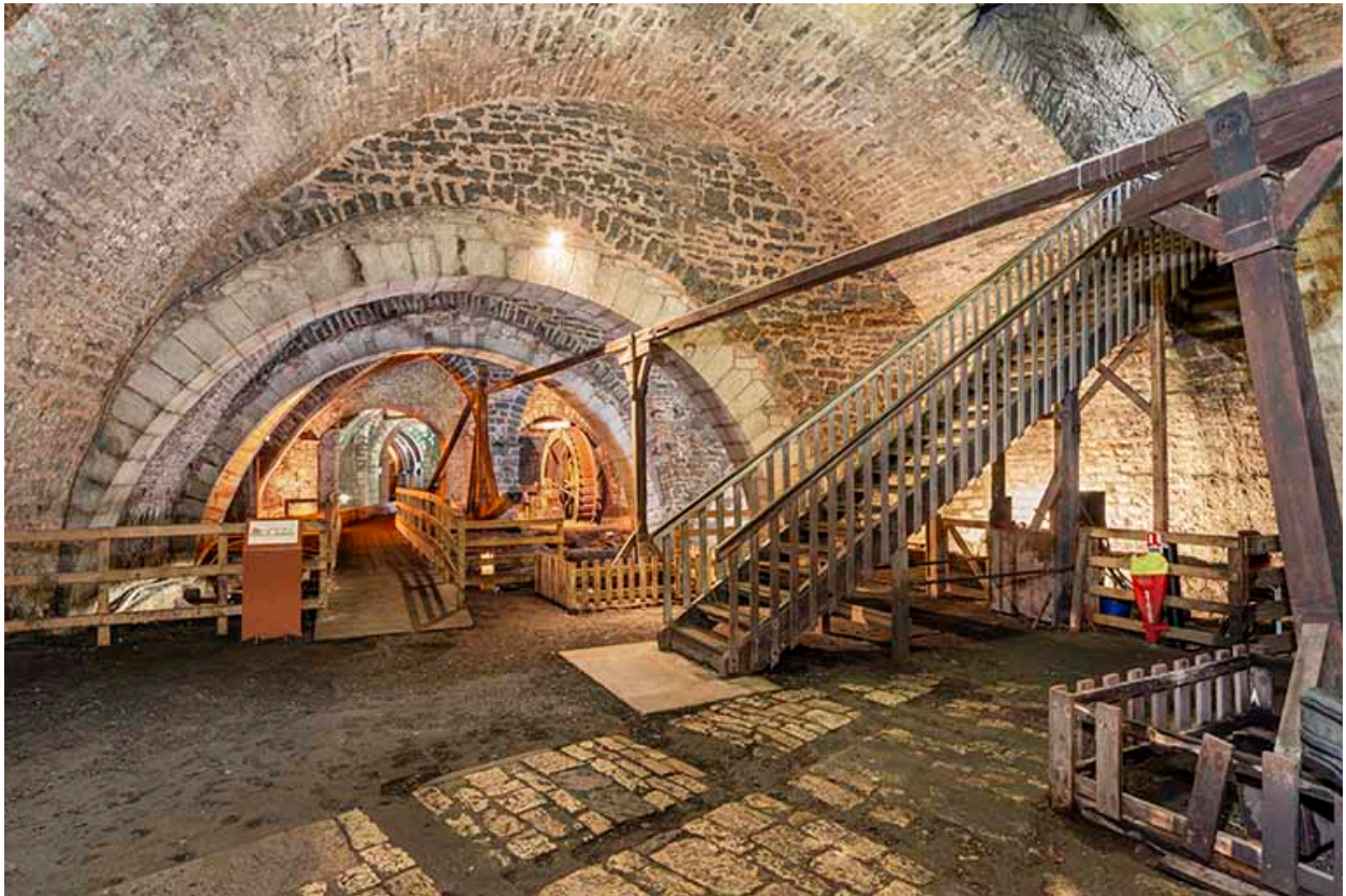
Puits d'Amont. Vue d'ensemble depuis le sud.
