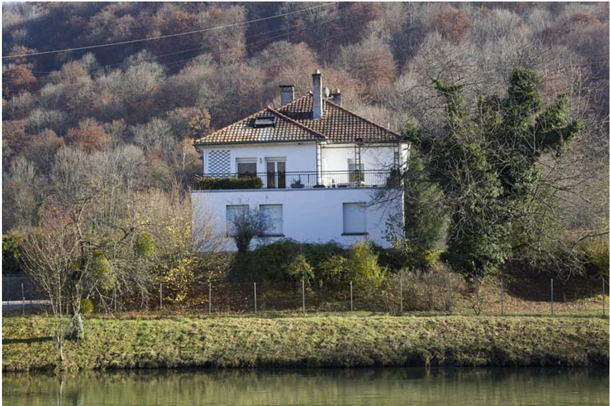
Le logement depuis l'ouest.
