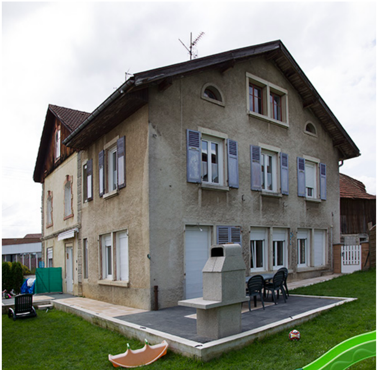
Logement patronal : façades postérieure et latérale droite.
