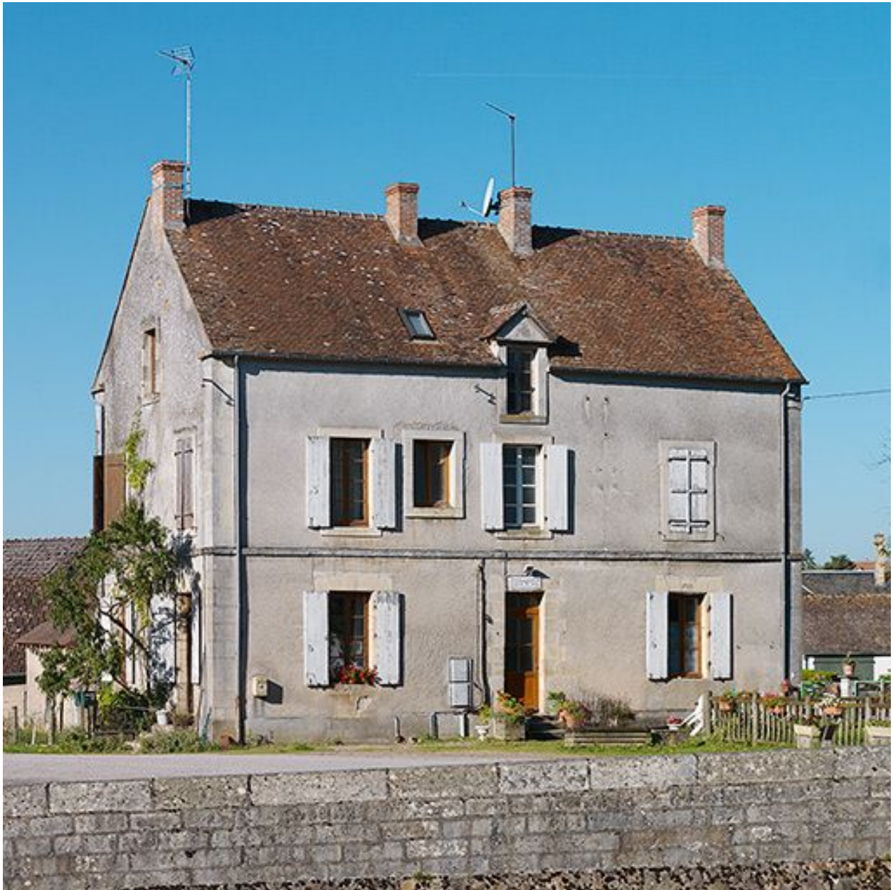
La maison éclusière de face.
