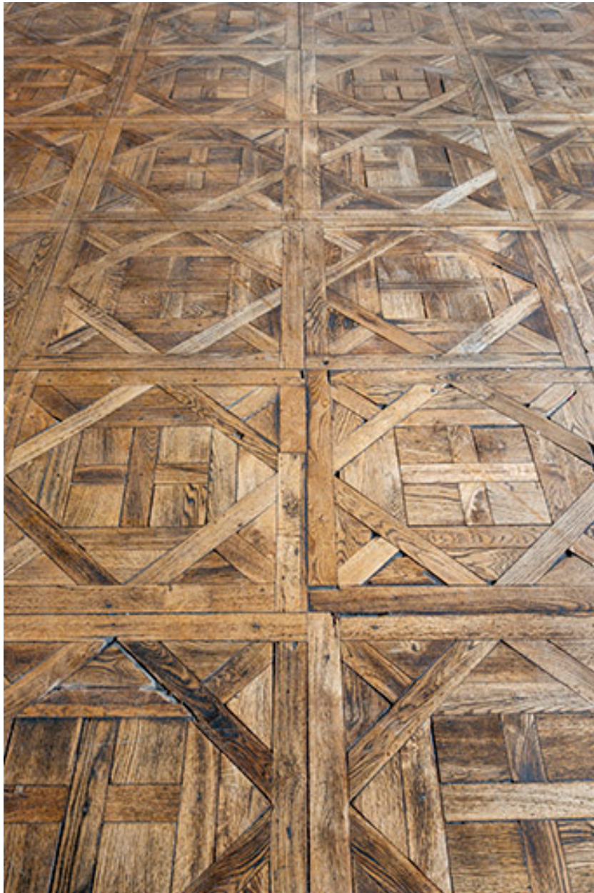
Ancienne salle du conseil. Détail du parquet.
