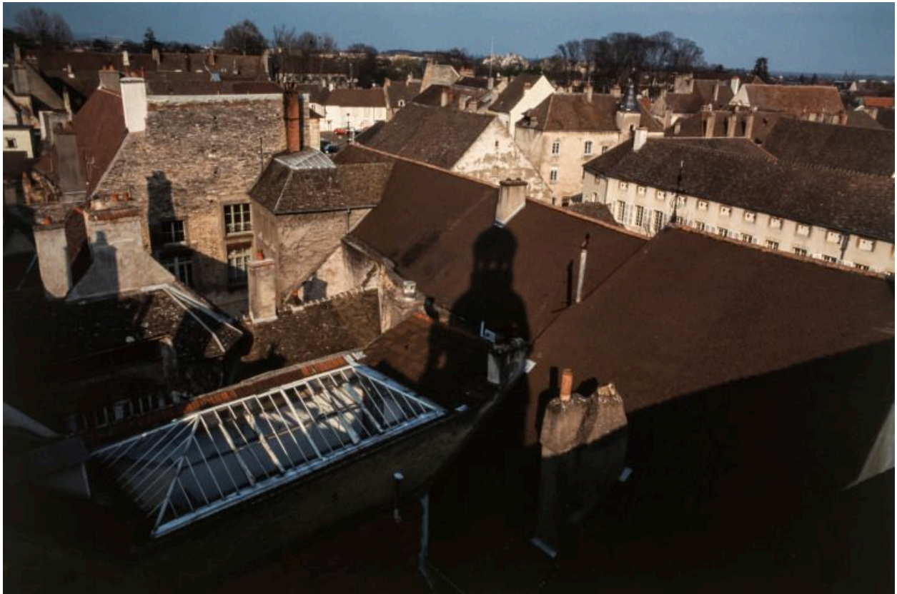
Toitures des différents corps composant le bâtiment de la Communauté des soeurs et des orphelines, vue prise du clocher de l'église.
