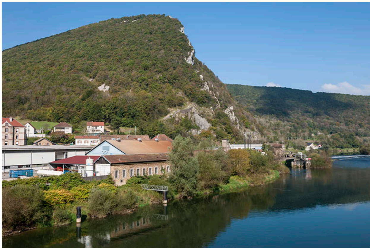
Vue d'ensemble depuis le pont en 2014.
