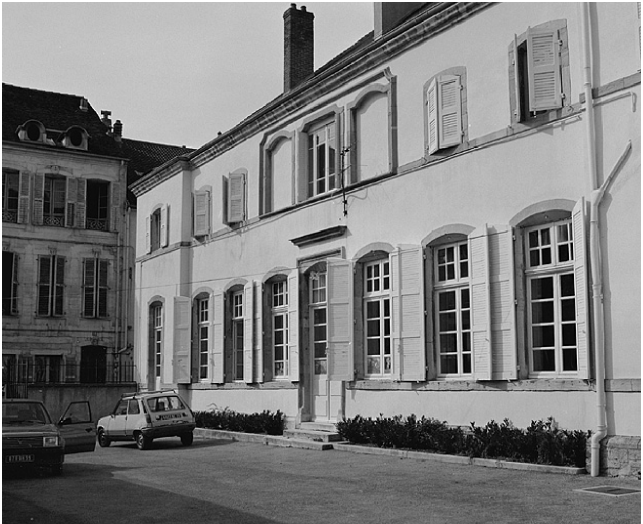
Façade postérieure, détail.
