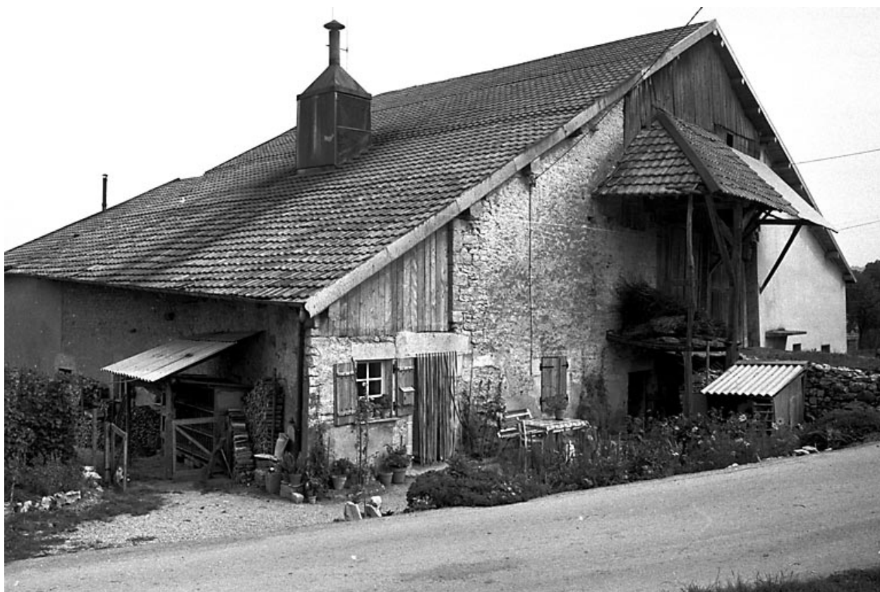
Trépôt : exemple de ferme bloc à parallèles (habitation double) sur le mur pignon.
