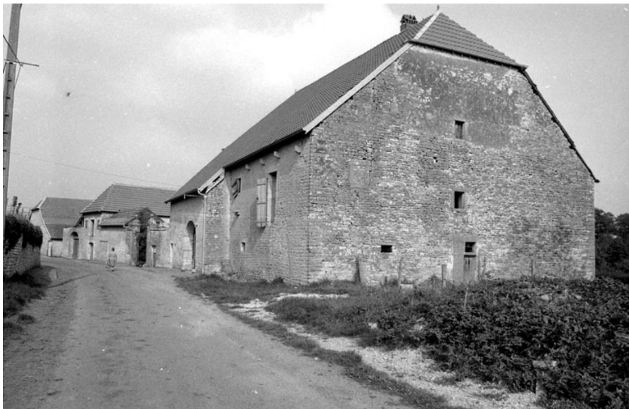
Façade antérieure et latérale droite.
