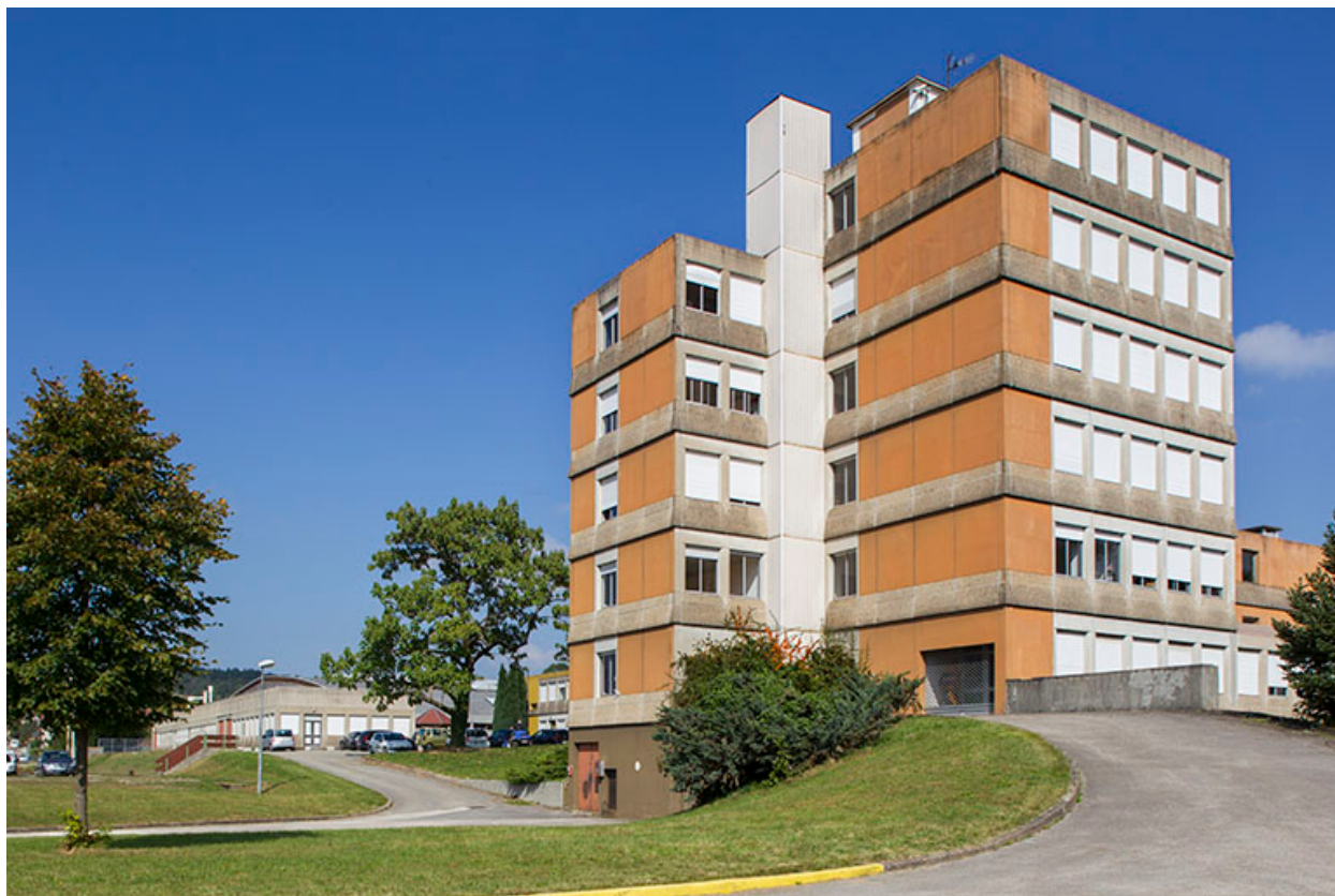
Administration et logements : façade ouest.
