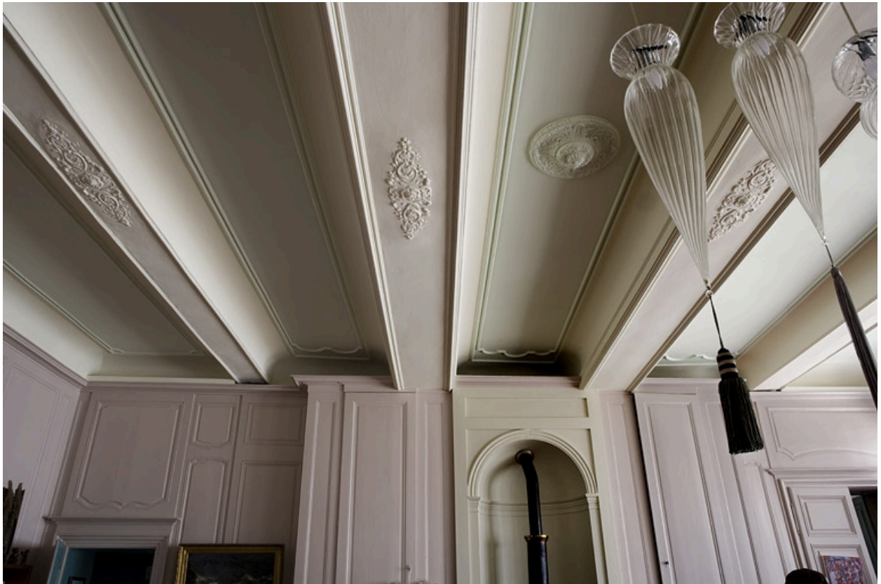
Intérieur, rez-de-chaussée : vue du plafond de l'antichambre.
