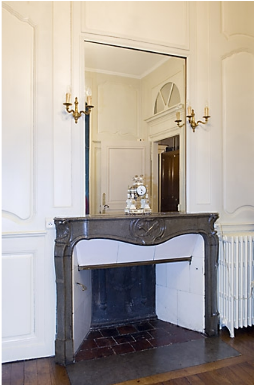
Détail d'une cheminée du premier étage.
