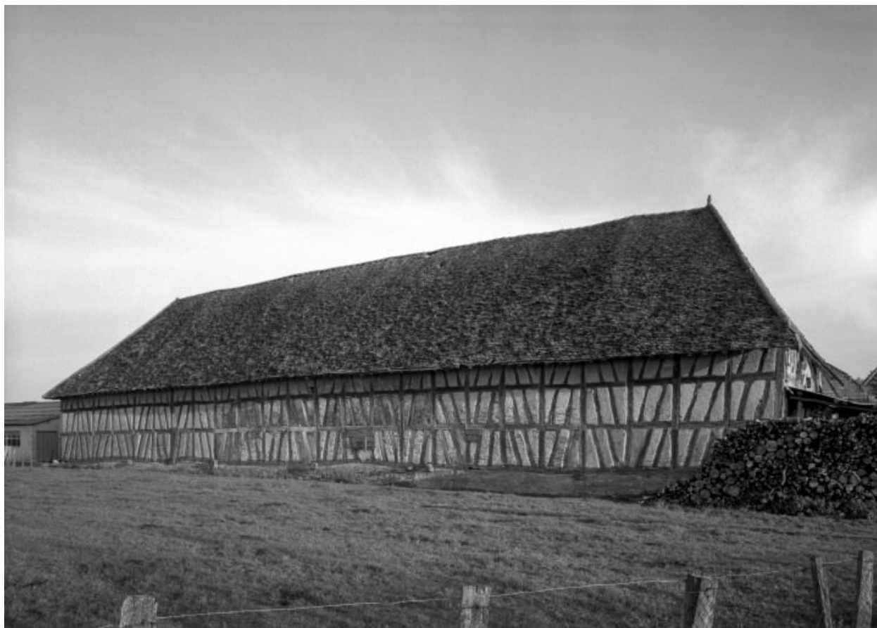
Bâtiment des dépendances, façade postérieure
