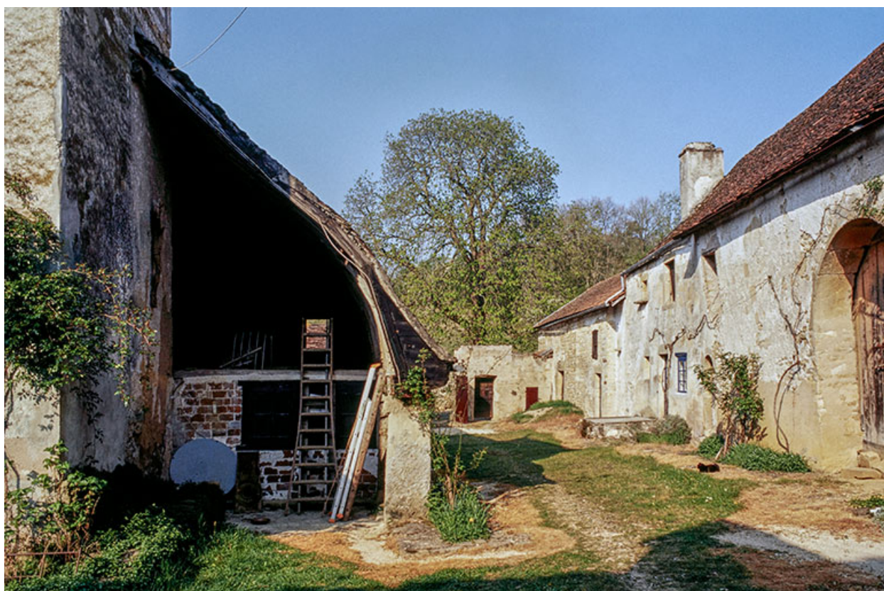
Vue de la cour depuis le logis en 2002.
