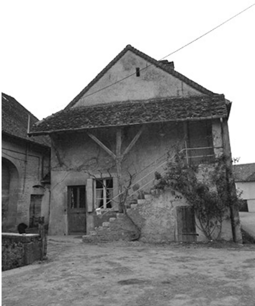
Ferme cadastrés 1961 AH 26, située rue des Guichard : façade antérieure.
