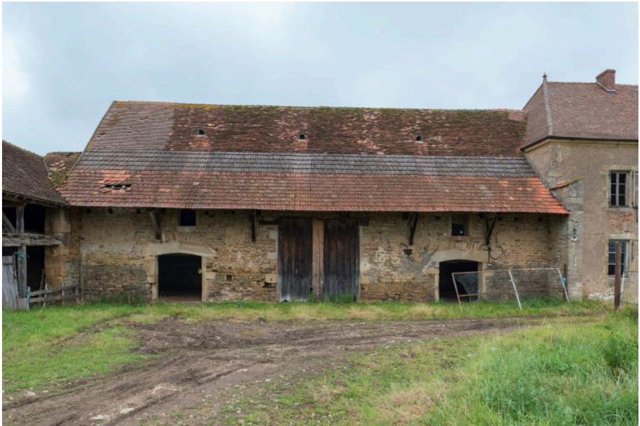
Façade antérieure de la grange
