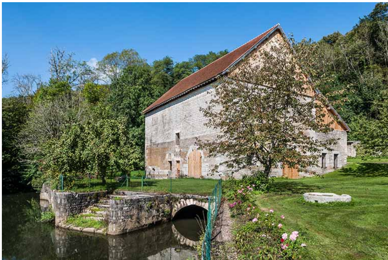
Bâtiment du haut fourneau depuis le sud-est.
