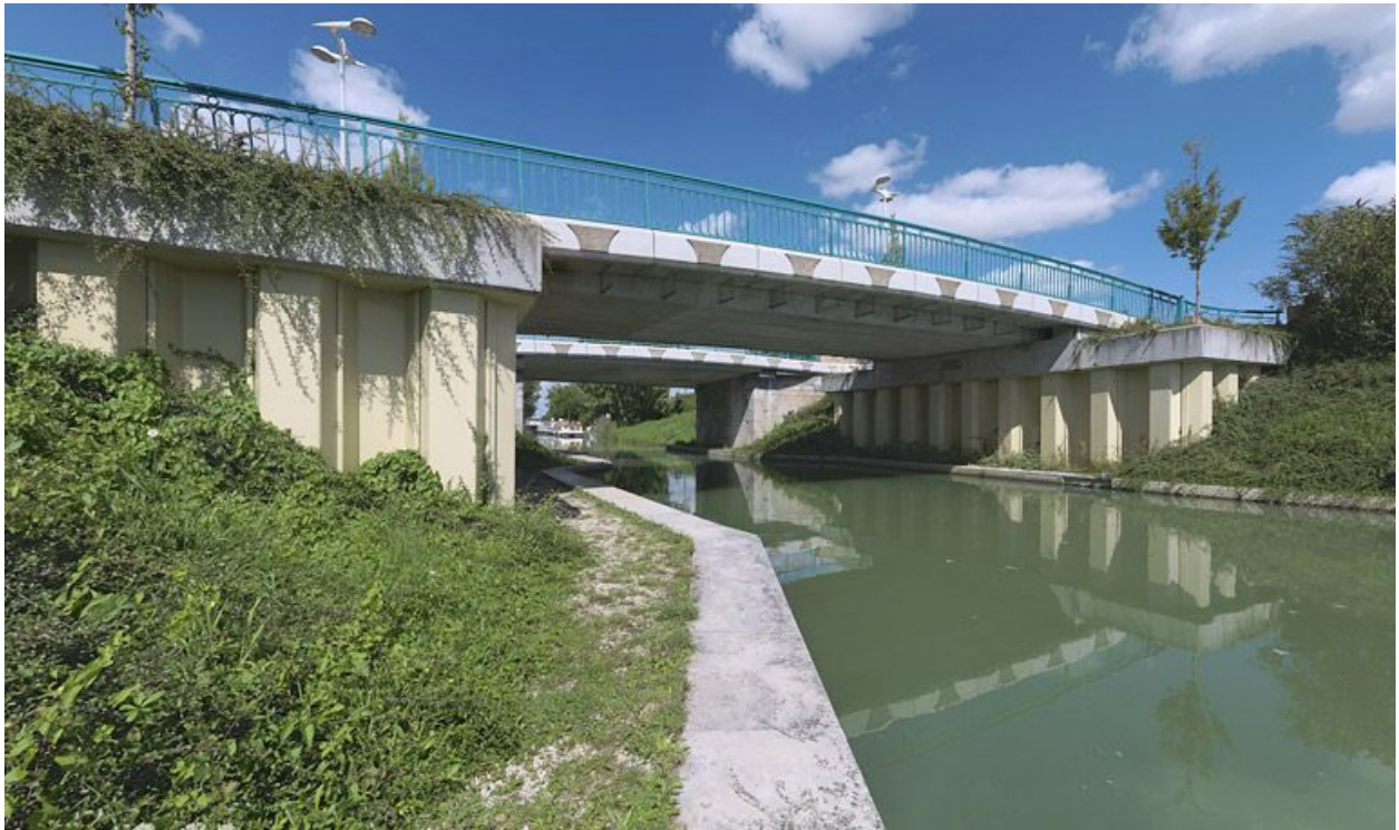
Vue d'ensemble prise d'aval.
