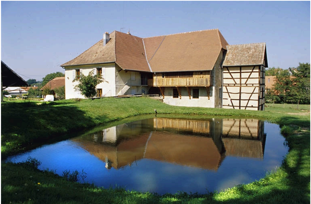
Façades postérieures du moulin.
