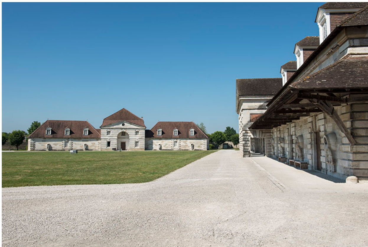
Logement des ouvriers et berne ouest.
