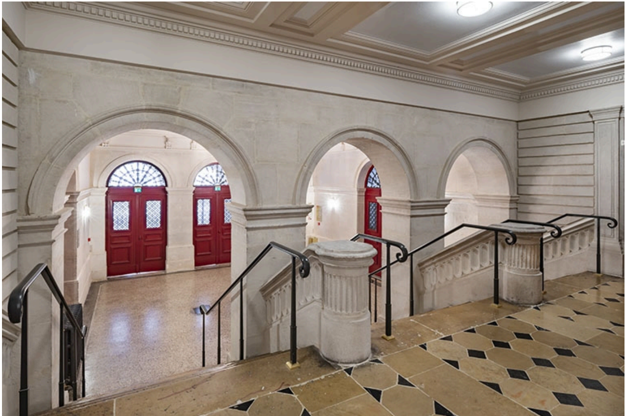
Vestibule : palier de l'escalier, de trois quarts.
