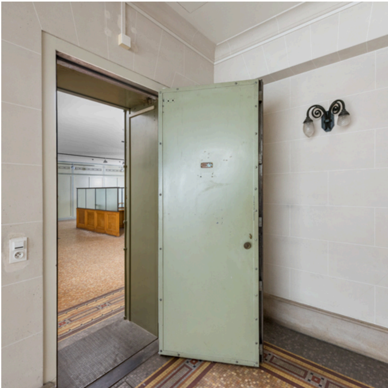
Sous-sol, salle des coffres, porte (vue depuis l'extérieur).
